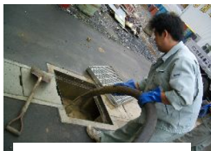
側溝マスの清掃
